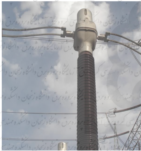
شکل (۱-۱): ترانسفورماتور جریان هسته بالا
